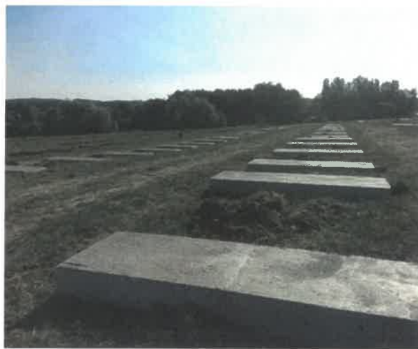
Exemple de mise en place de longrine - (Source : ENGIE PV PARGNY LES REIMS)
