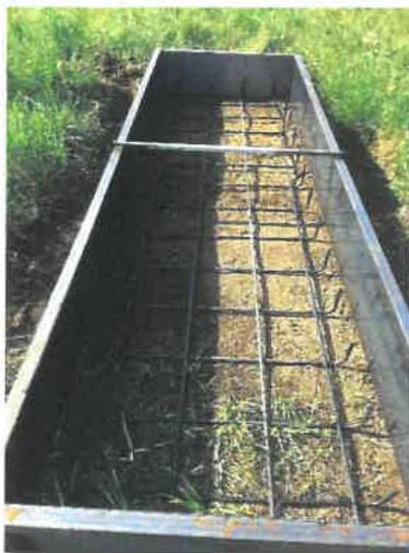
Exemple de mise en place de longrine - (Source : ENGIE PV PARGNY LES REIMS)
